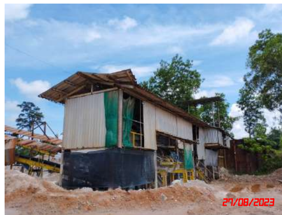
อาคารปิดคลุมโรงโม่หินและปิดคลุมเครื่องบด
